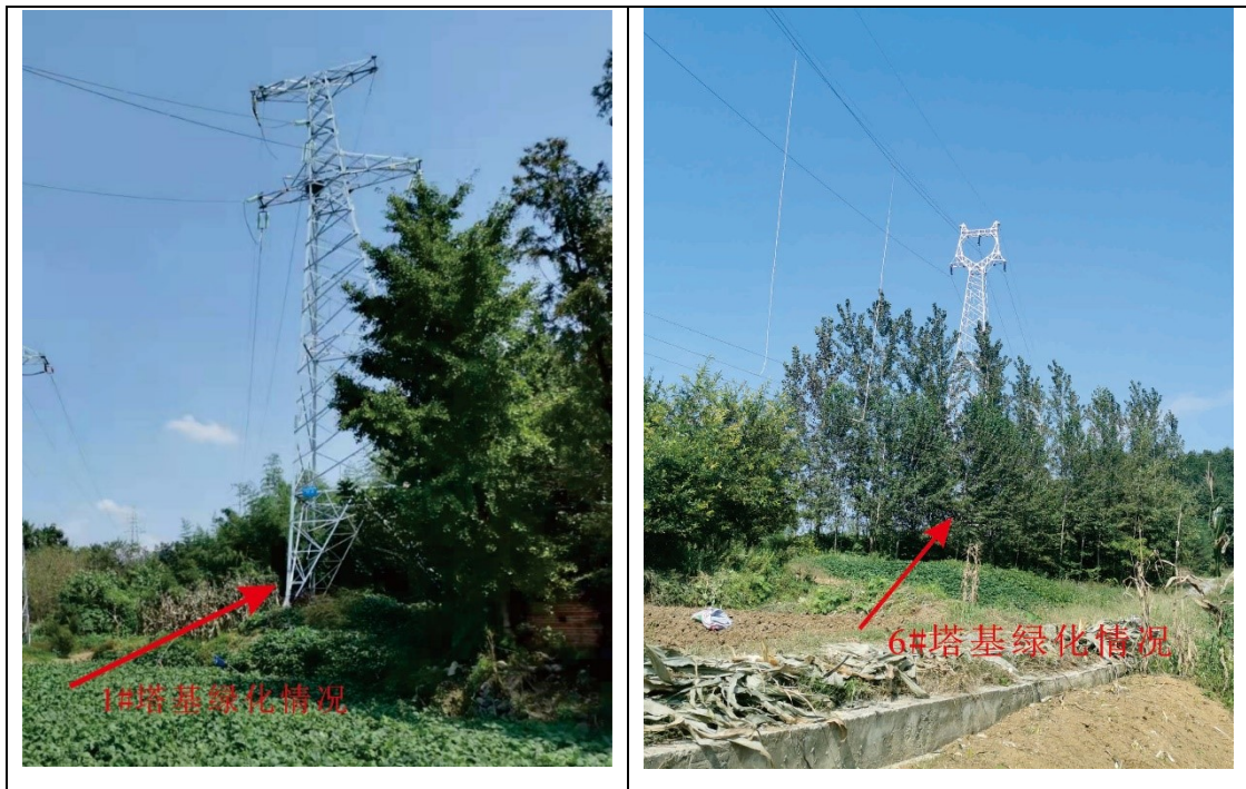
图 4-3 已建塔基周边绿化情况
