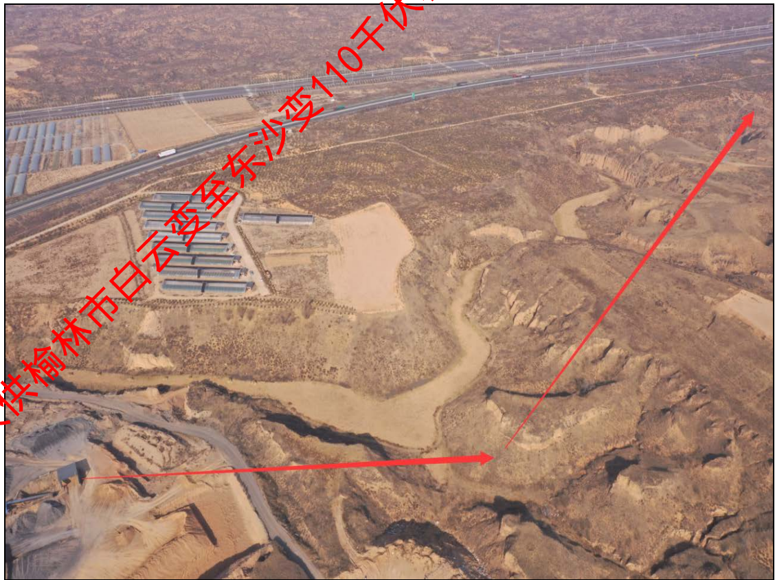
图3-1 线路拟跨越的明长城遗址-榆阳段现状
