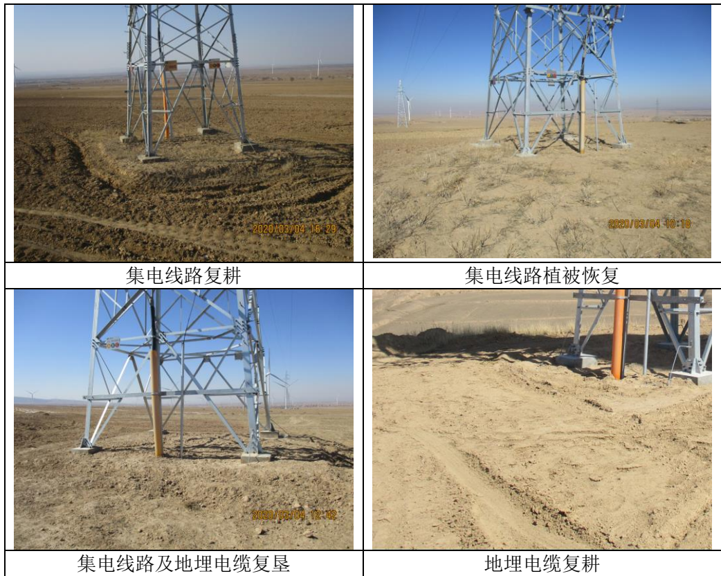
图 7-5 集电线路、地埋电缆临时占地恢复情况
