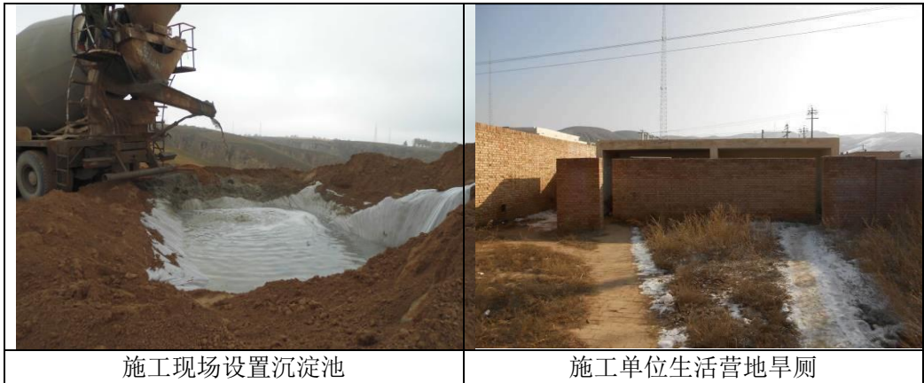
图 7-2 施工水污染防治措施
