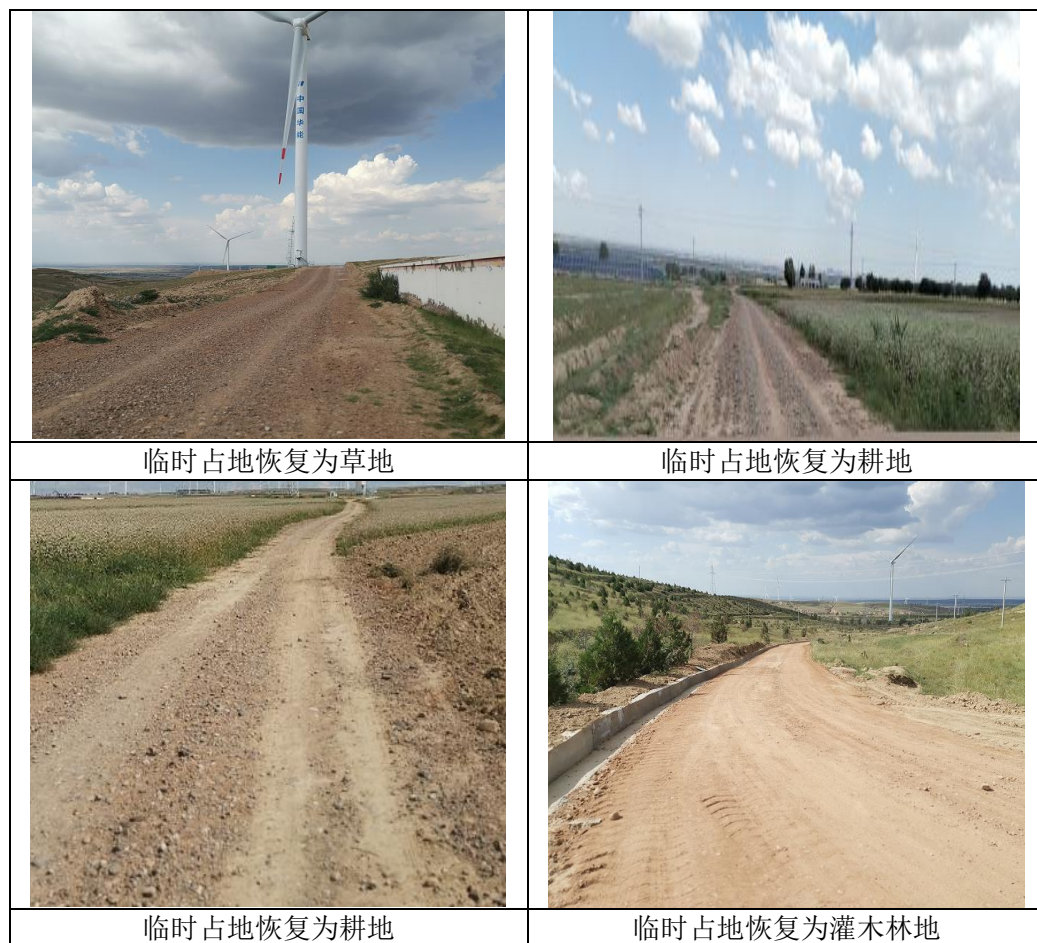
图 7-4 场内道路临时占地恢复情况
